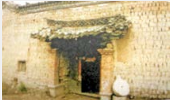
位于马龙县鸡头村（今马龙区鸡头村街道）的红一军团部驻地旧址
