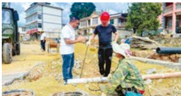
普洱市思茅区南屏镇曼连社区人居环境提升改造现场
