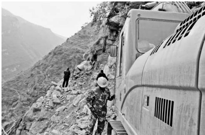
手扒岩公路施工现场
