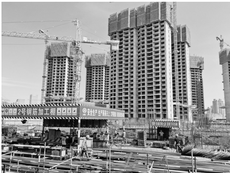
云报传媒广场建设项目工地
