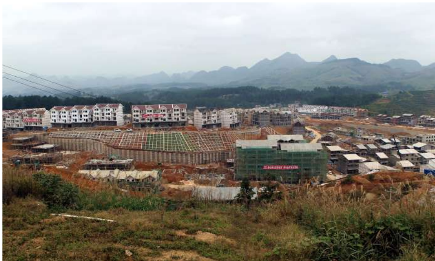
正在建设中的克度马鞍移民安置点
