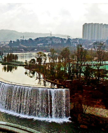
重力落差方式为注入滇池的水补充氧分
