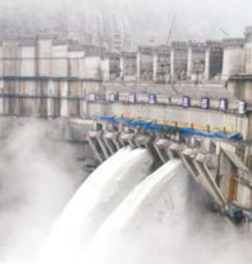
溪洛渡水电站 南方电网供图
