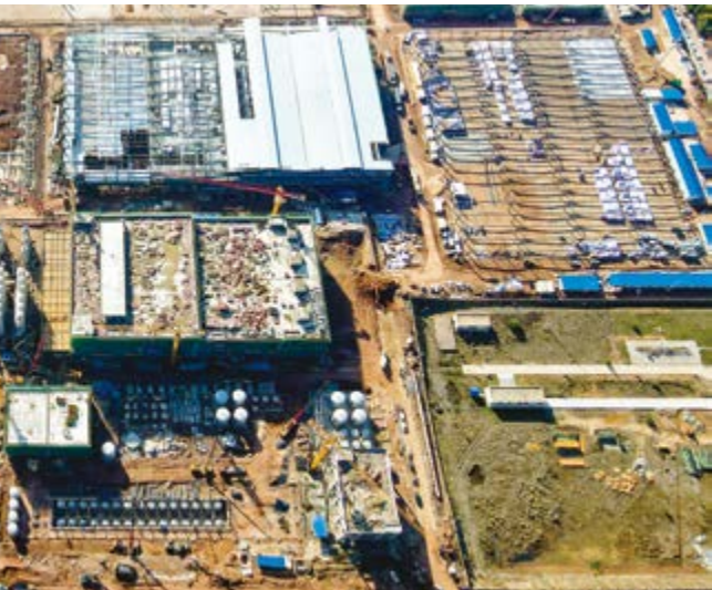
德枋亿纬有限公司纳米磷酸铁锂新材料项目建设基地 刘宇 📍
