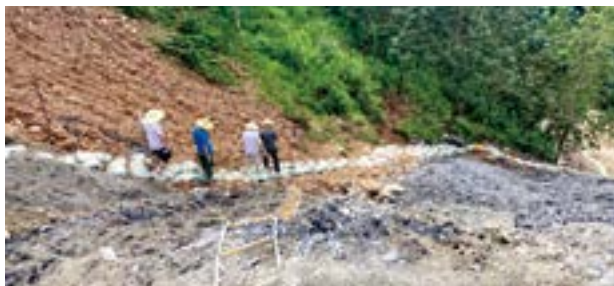
省应急管理厅工作组赴绿春县指导“9·16”泥石流救灾工作 吴煜梓
